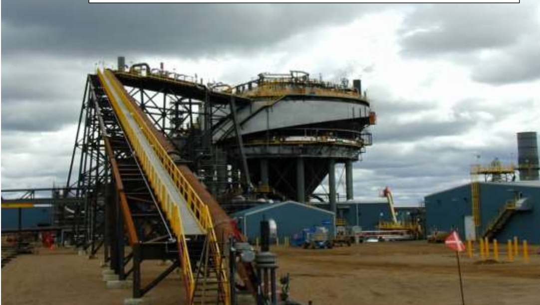
写真 3 抽出セクション (建設中の PSV) (筆者撮影)
